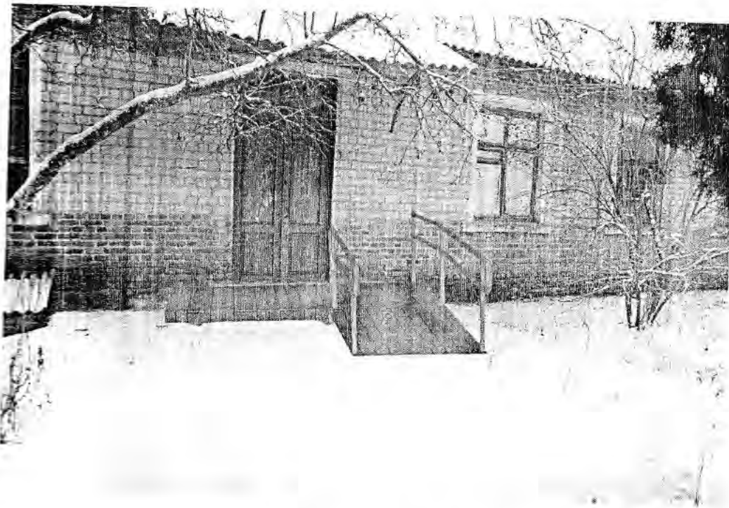
Загальний вигляд пандусу
