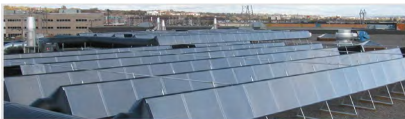
Рис. 6. Геліополе повітряної ГСТ на основі колекторів Luba GL в Монреалі
