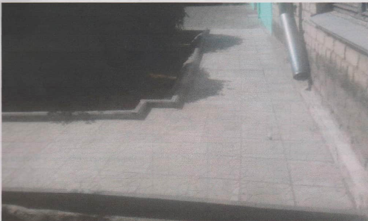
Рисунок 4.3 – Загальний вид елементів вищого ярусу, проміжної посадкової площадки пандусу
